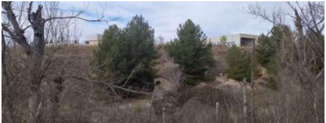
Imagen 22 Ejemplo de obras de vertido a la rambla Gavarnera. Fuente: Proaguas Costablanca.
