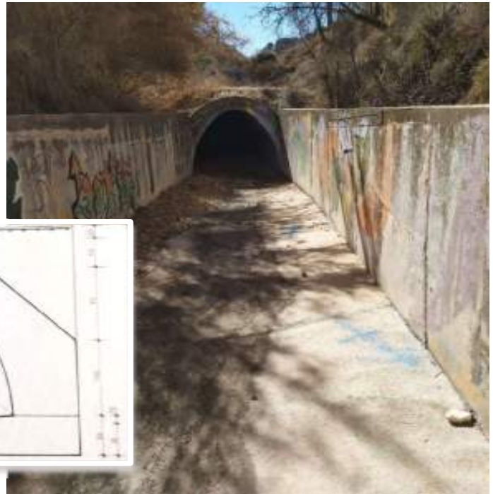
Imagen 26 Comienzo del tramo cubierto y sección constructiva del encauzamiento del Riu de les Caixes'. Fuente: Ayuntamiento de Ibi.
