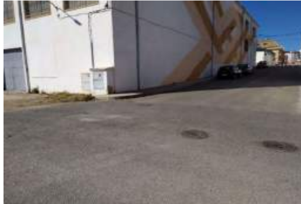
Imagen 20 Instalación enterradas de bombeo de la Calle Camilo José Cela. Fuente: Proaguas Costablanca
