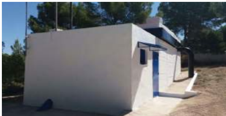
Imagen 11 Arqueta rotura de carga Villalobos. Fuente: Proaguas
